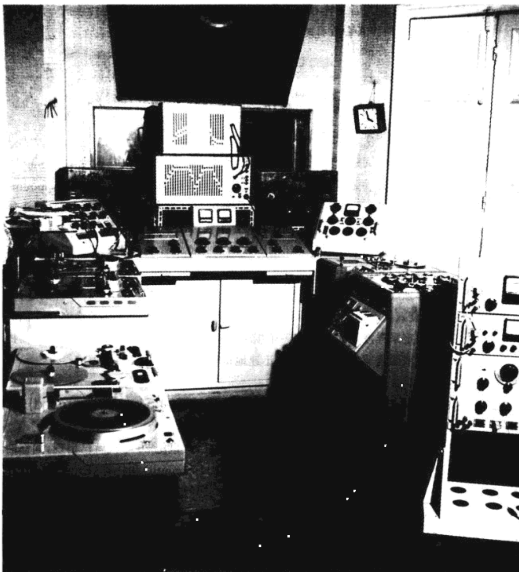
图 4.1 1960 年舍费尔(Pierre Schaeffer)的具体音乐工作室,位于 rue de l'Université, 巴黎。工作室左方有三台磁带录音机,以及一个电唱盘。右边是另一台磁带录音机,以及多拾音头的“浮诺振”(Phonogène)器材(见图 4.2)。(照片由巴黎 Groupe de Recherches Musicales 所提供)
